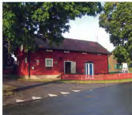
Museet är inrymt i en tvåvånings träbyggnad. Foto Ingemar Nilsson.
